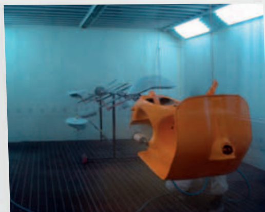
... riscaldamento di cabine di verniciatura
